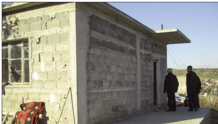
Huset i desember - med nytt tak og ny trapp.
